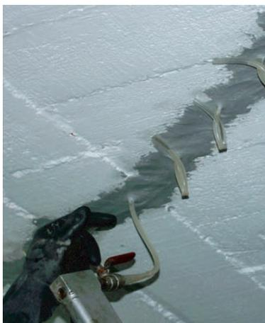
Fig. 3 - Injeção de resina epoxídica para reparação de betão
